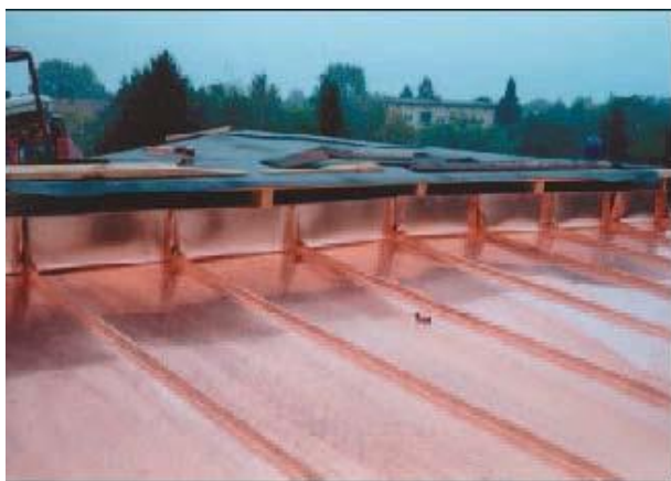
Рис. 7 Фальцевая кровля
